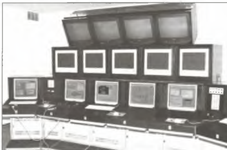
Рис. 15.14. Унифицированный пульт контроля и управления тренажерного комплекса МКС (ПКУ модуля "Звезда")
