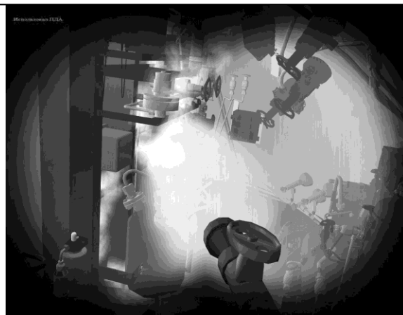
Рис. 3. Применение раздвижного упора для ликвидации пробоя (слева) и использование пенного огнетушителя при ликвидации возгорания (справа)
