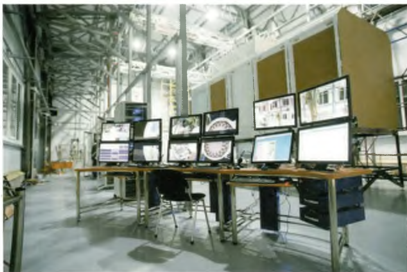
Пульт контроля и управления
